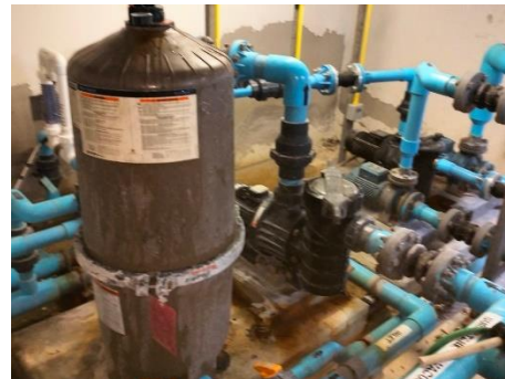
ระบบกรองน้ำสระว่ายน้ำ (ระบบเกลือ)
